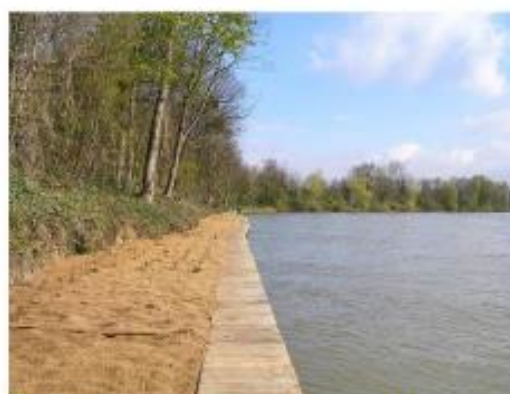
Traitement paysager - génie végétal lors des opérations de confortement du bras de Marly Plantations de fascines de saules et mise en place de roselières
